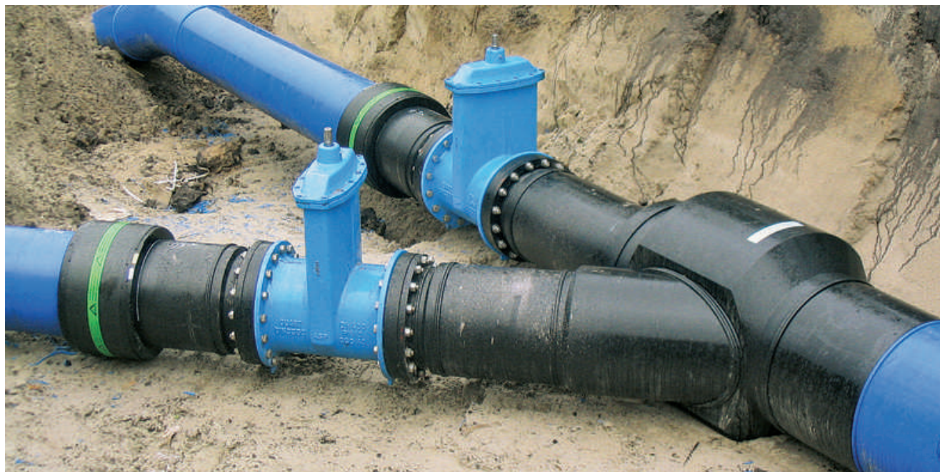
PE100 T-stykke med 45° afgrening d70 / d500 mm SDR17 / 11
