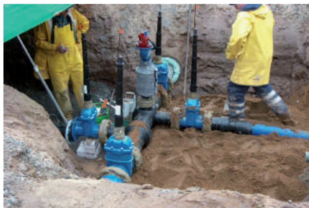
PE100 Kryds med vertikal afgrening med brandhane d225 / d160 mm SDR11
