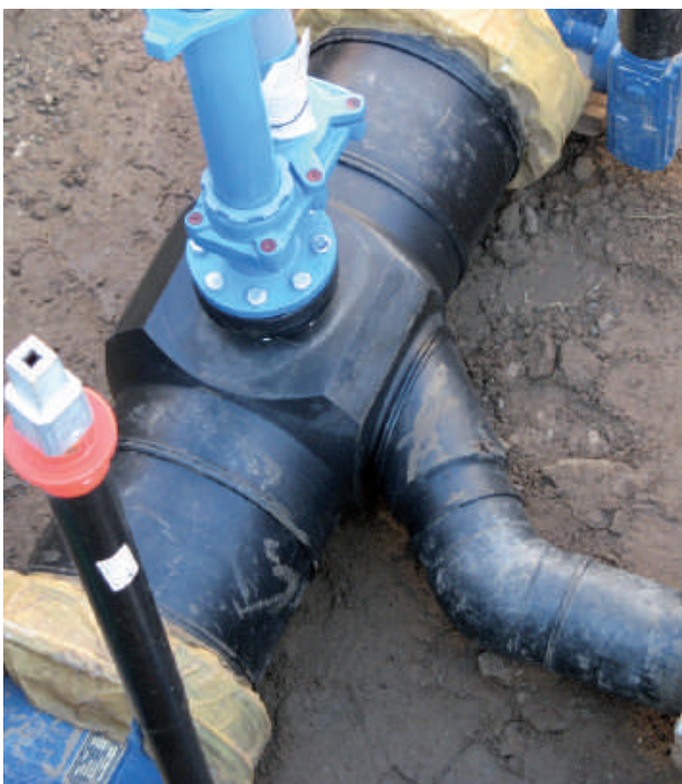
PE100 Kryds 45° med brandhane DN 300 / d225 mm SDR17
