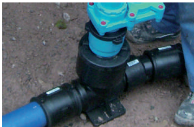
PE100 T-stykke, d225 mm SDR17 drikkevandsledning
